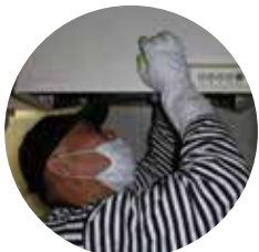
換気扇掃除中
